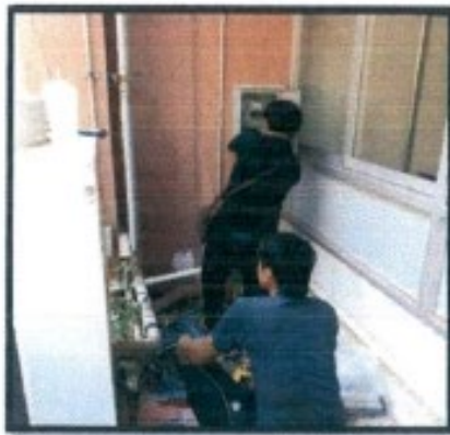
การติดตั้งระบบเติมอากาศ
